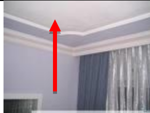
Het plafond Le plafond The ceiling
