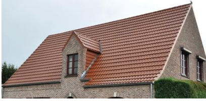
Het dak Le toit The roof سقف Cati
