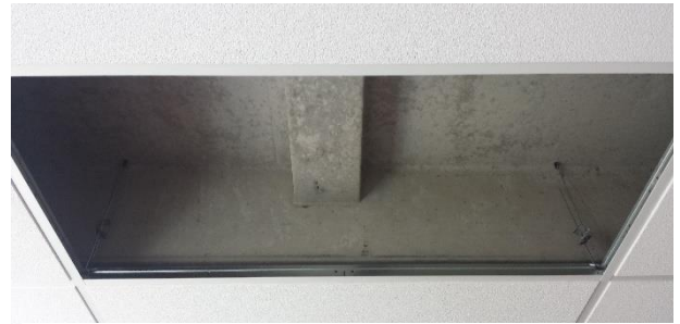
Figuur 28: Foto van ruimte boven het vals plafond met dwarsbalken
