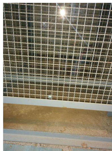
Figuur 13: hekwerkopeningen onderaan de cellen
