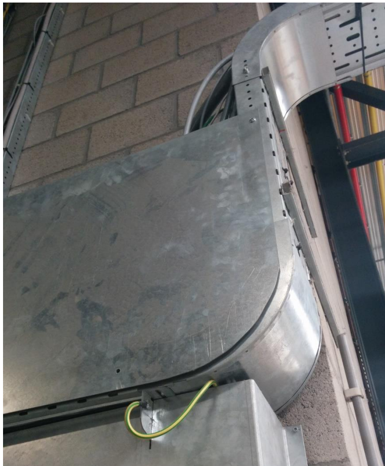
Figuur 24: voorbeeld equipotentiaalverbinding
