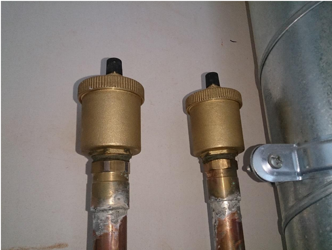
Figuur 12 Automatische ontluchters
