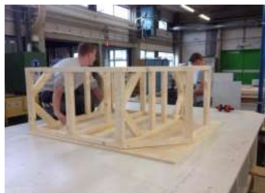
Figuur 26: Brecht_Geraamte plaatsen
