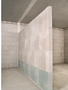
Figuur 44: Scheidingswand van gipsblokken goo.gl/WK5iWL
