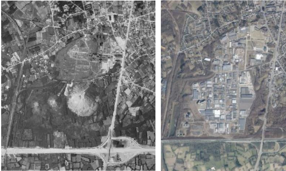
Figuur 2a en b: Situatieschets Centrum-Zuid voor (a, links) en na (b, rechts) het platduwen van de terrils (1971 - heden) (Geopunt Vlaanderen, sd)
