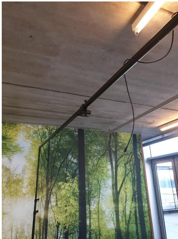
Figuur 21: Close-up bevestiging GoPro
